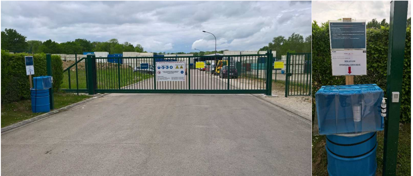
Premier portail du sas d'accès aux véhicules. Fermé, accès à code et interphone. Consigne pour le personnel externe.
