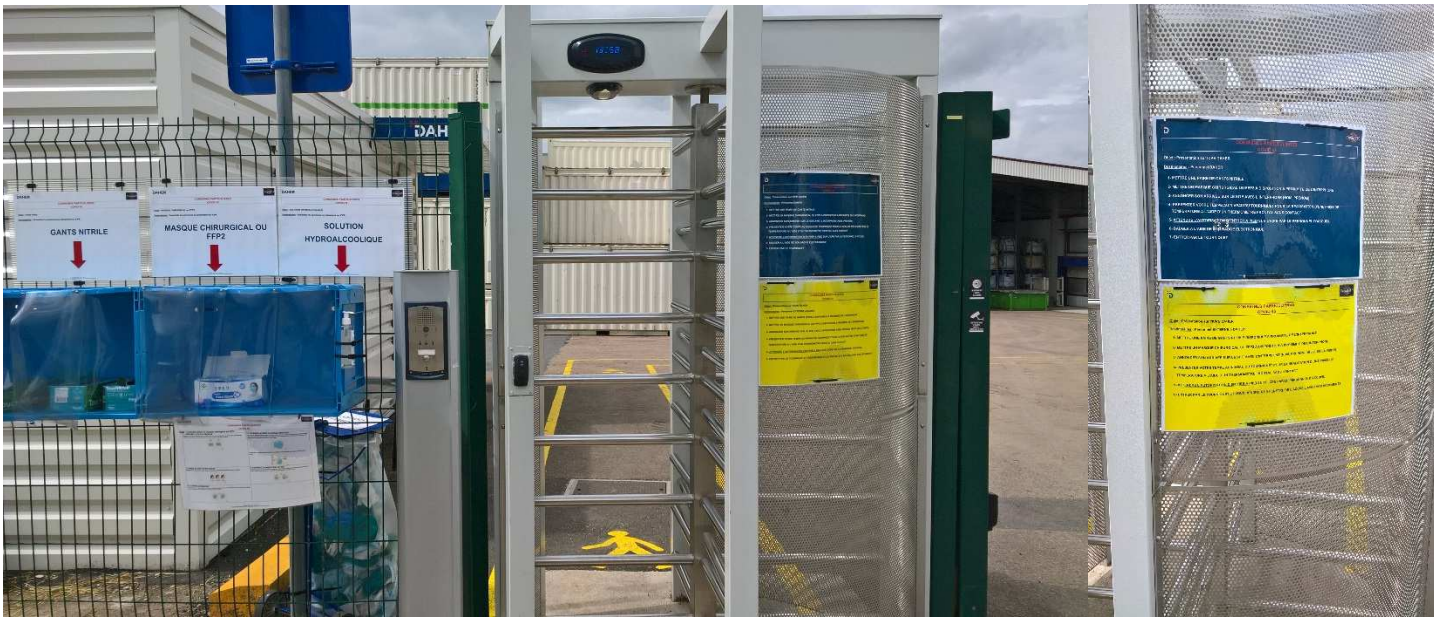
Deuxième portail du sas d'accès véhicule et tourniquet accès piétons. Consigne pour le personnel externe (jaune) et interne (bleu). Gel hydro alcoolique, gants vinyle et masques FFP2 sont fournis.
