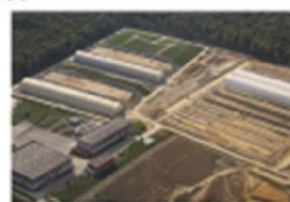
Centre industriel de regroupement, d'entreposage et de stockage (Cires) - en exploitation
