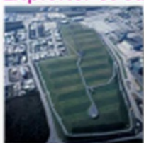
Centre de stockage de la Manche (CSM) - en surveillance
