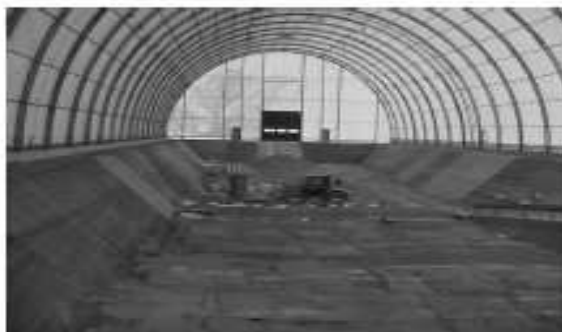
CSTFA : Intérieur d'une alvéole de stockage
