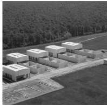
CSFMA : ouvrages de stockage des déchets
