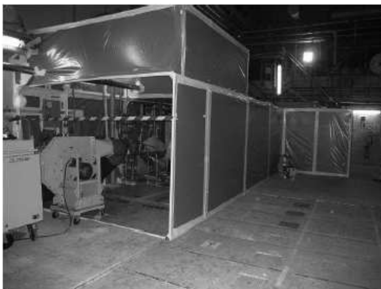
Sas en cours de montage pour un chantier du démantèlement dans la caverne « combustible »
