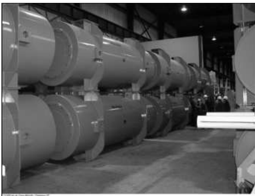
Entreposage des colis PNL sur Superphénix
