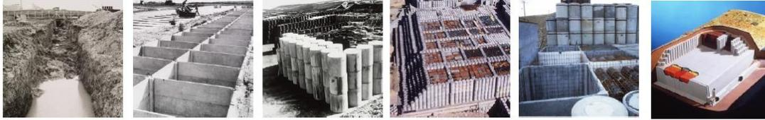
Stockage en pleine terre    Stockage en tranchées béton et plates-formes    Stockage en tumulus et monolithes    Concept multi-barrières
