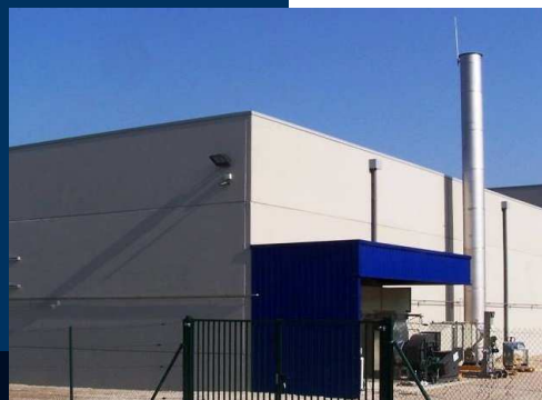
Ventilation nucléaire et cheminée
