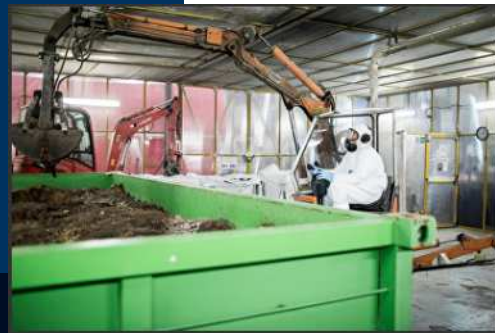
Reconditionnement de terres et gravats
