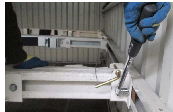
Calage avec serrage au couple
