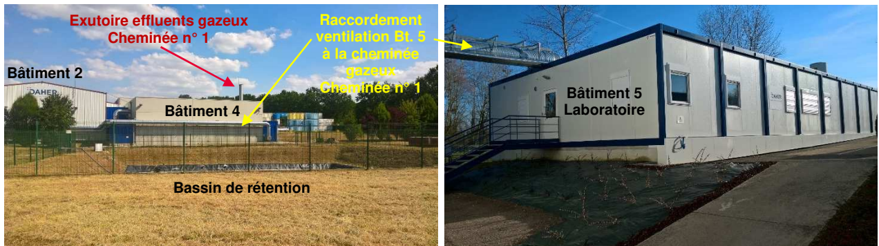
Figure 8 : Bâtiment 5 (Laboratoire) et raccordement de la ventilation à la cheminée, unique exutoire
