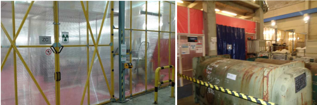
Figures 20 : Façade externe du SET-GV et façade externe sas « déchets radioactifs amianté »
