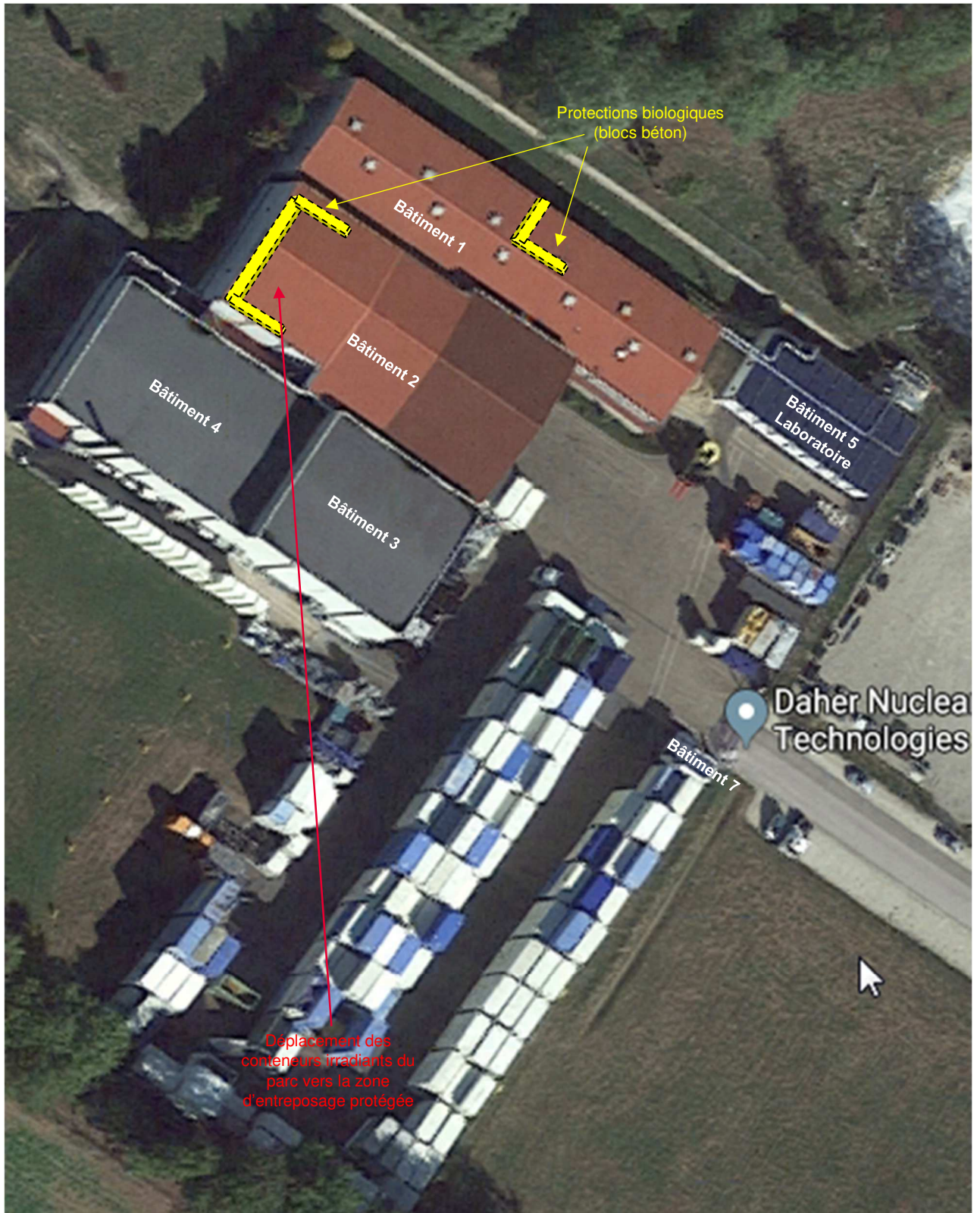
Figure 4 : ICPE telle qu'exploitée en 2020, installations
