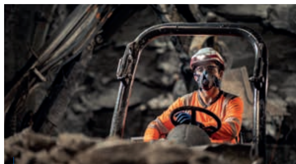
Transport des déblais de creusement.
