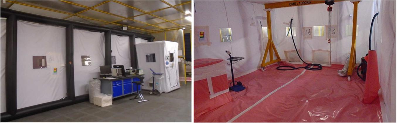
Figures 21 : Façade externe du SET-GV et internes du sas pour le traitement de « déchets radioactifs amianté »
