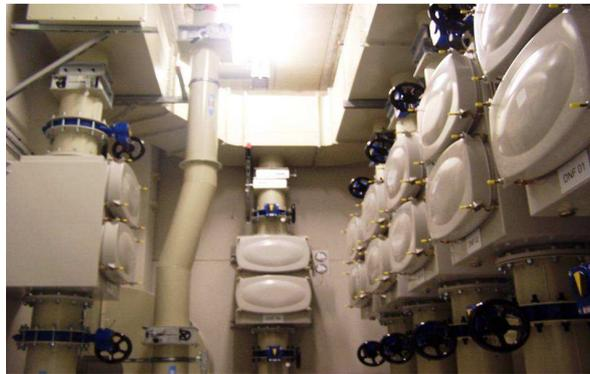
Figure 7 : Les 7 lignes de doubles filtres THE des bâtiments 3 & 4, et la cheminée des bâtiments 3, 4 & 5
