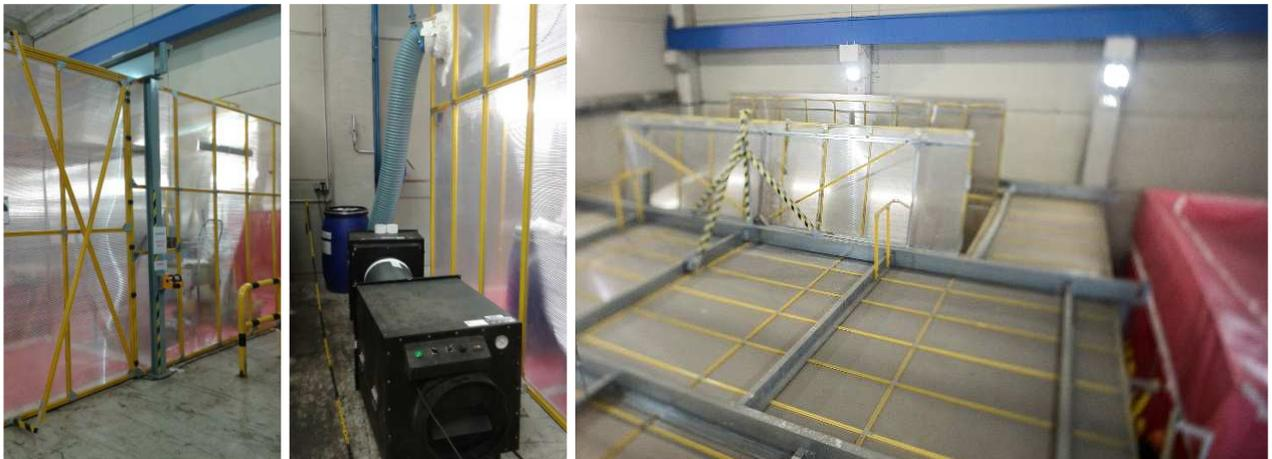
Figures 10 : Sas autonome SET-GV en hall d'entreposage, façade, groupe filtration THE & toit ouvrant
