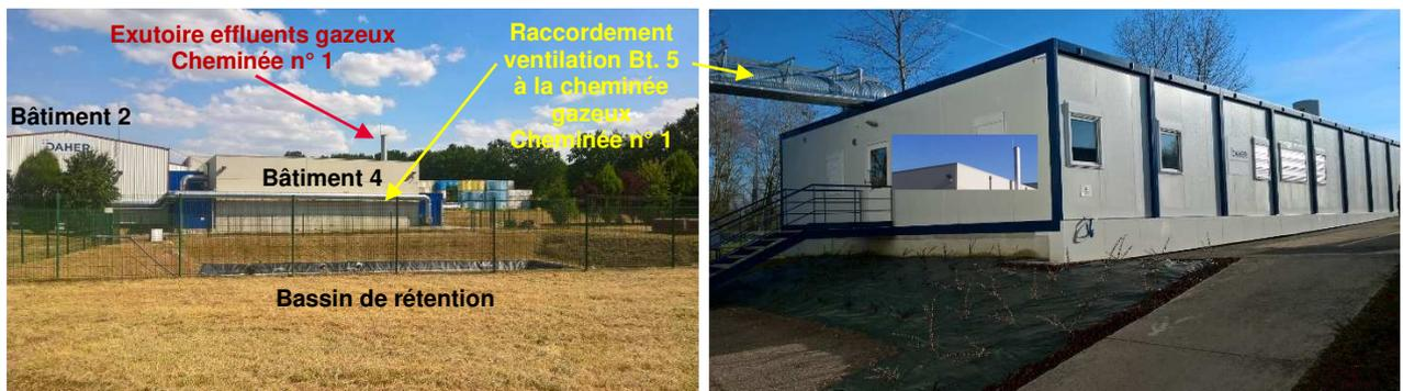
Figure 8 : Bâtiment 5 (Laboratoire) et raccordement de la ventilation à la cheminée, unique exutoire
