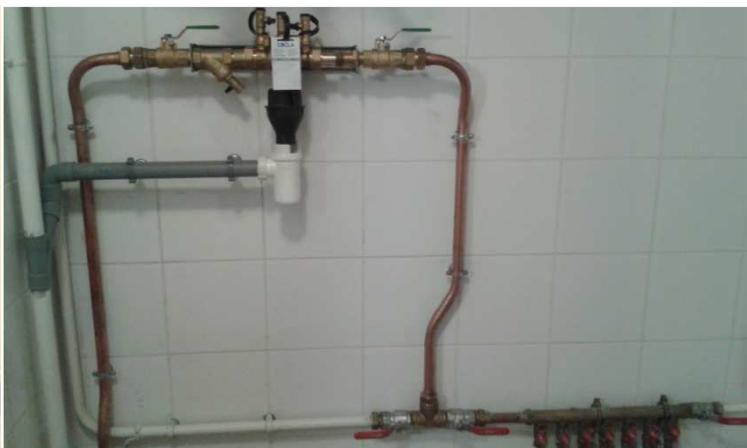
Figure 12 : Disconnecteur dans couloir d'accès aux bâtiments 4 & 3
