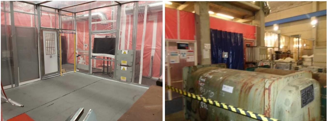
Figures 22 : Façade externe du sas de traitement des déchets amiantés « moteurs d'avion »
