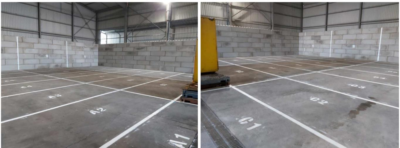
Figure 19 : Aménagement du fond du bâtiment 2 en aire d'entreposage provisoire des emballages les plus irradiants, avec protections biologiques (blocs béton) en périphérie pour limiter la dosimétrie du personnel.
