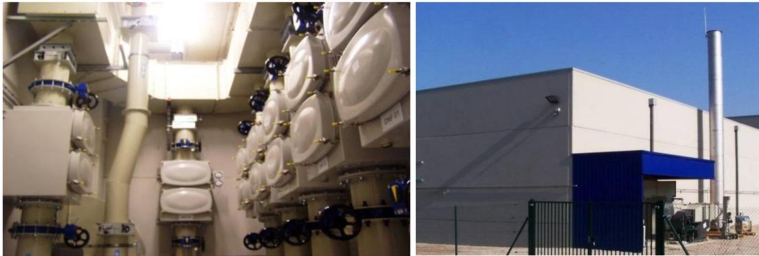
Figure 7 : Les 7 lignes de doubles filtres THE des bâtiments 3 & 4, et la cheminée des bâtiments 3, 4 & 5
