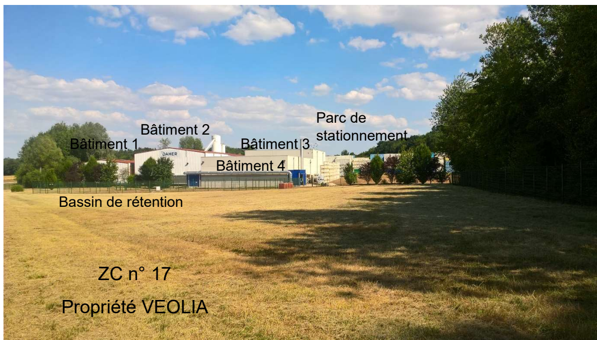
Figure 6 : Situation actuelle de l'ICPE, vue de la RD400 côté ouest, installations
